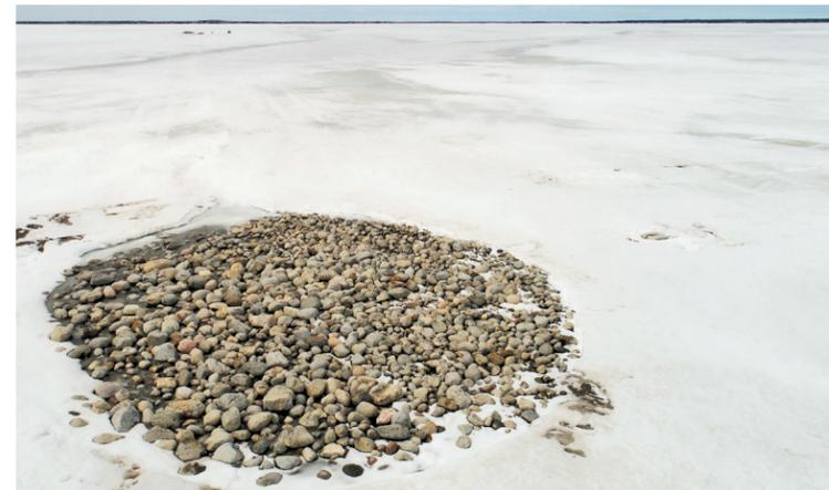
Figure 2: Frayère artificielle exondée suivant sa construction à l'hiver 2017.
